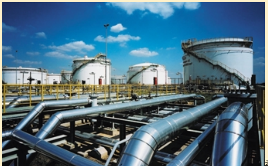
Top-Holding des Schroder Global Energy: TOTAL Raffinerie Mitteldeutschland GmbH.
